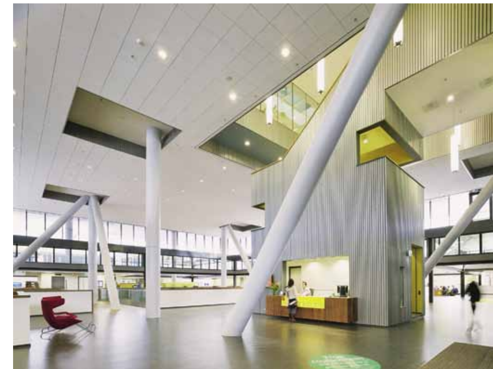
De ranke staalconstructie van de bovenbouw prikt met twintig ranke kolommen door de oorspronkelijke constructie van de hal heen. Fotograaf Petra Appelhof
